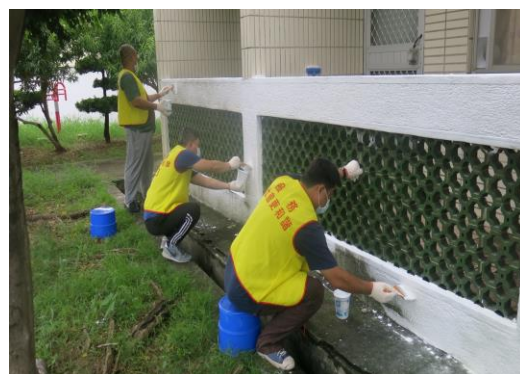
建築物油漆粉刷作業
